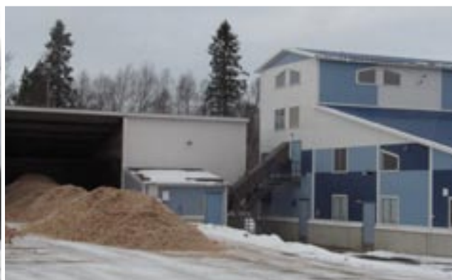
Тепловая электростанция в "Ivalo Center", город Ивало.
