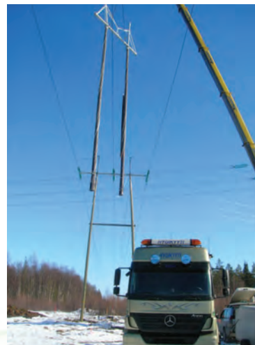
Työ toteutettiin neljällä työryhmällä, henkilömäärä oli yhteensä 20. Vanha pylvästys korkeasta iästään huolimatta oli pääosin hyväkuntoista, joten voidaan olettaa, että uudet betonipernustet pylvääit kestävät seuraavat 100 vuotta.
