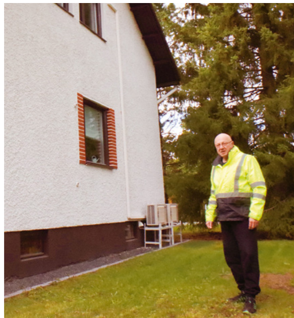
Rakennusinsinööri, AKK Harri Halonen kuvassa aloitamassa vuonna 1954 valmistuneen omakotitalon kuntotarkastusta Forssassa. ”Tässä kohteessa katovedet oli johdettu oikeaoppisesti rännikaivoon ja imeytetty maahan vähintään kolmen metrin päässä perustusrakenteista. Perustuksen ulkopuolella näkyy puolen metrin kivetyksistä. Kasvillisuuttahan ei saa olla sokkelin vierellä.”
